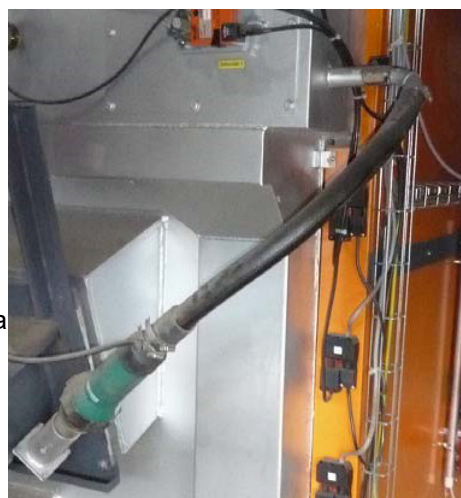
Фиг. 6 Автоматично запалване шнек подаващ горивото в огнището
