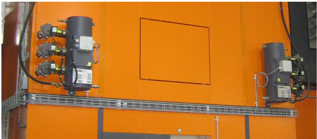
Abb. 7 Feuerungsanlage mit automatischer Zwischendeckenabreinigung
