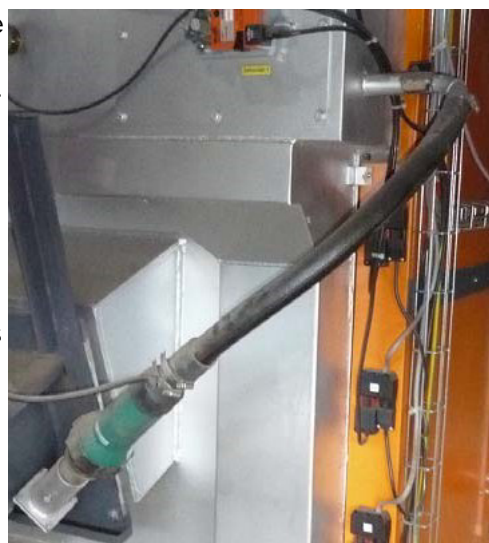
Fig. 6 Allumage automatique vis d'alimentation
