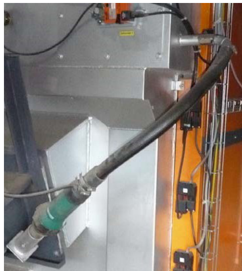
avb. 6 Automatisk tenning stoker
