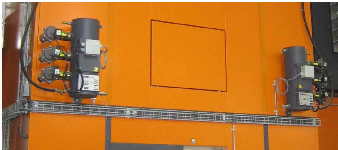
Bild 7 Förbränningsanläggning med automatisk mellantakrengöring
