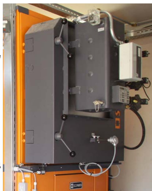
Фиг. 6 Автоматично почистване на котелните тръби
