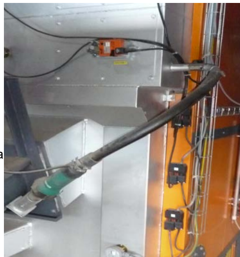
Фиг. 7 Автоматично запалване
